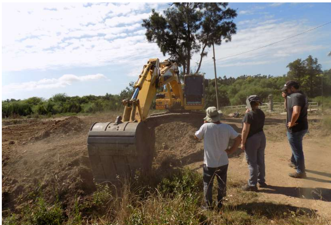
Tareas de excavación en el Batallón No. 14.
