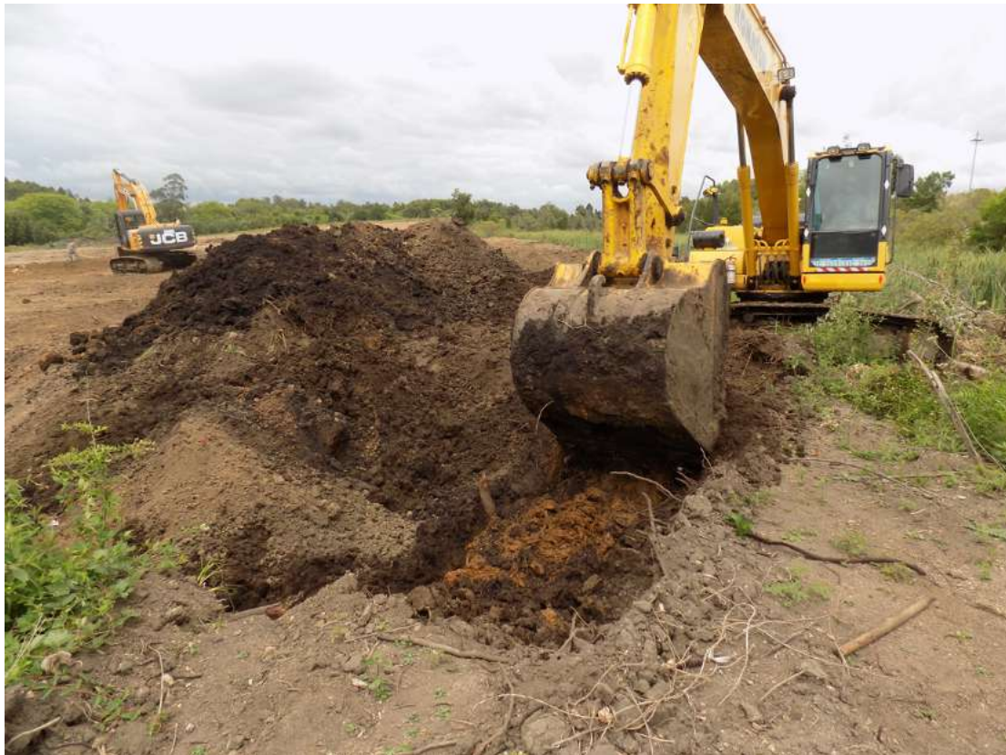
Tareas de excavación en el Batallón No. 14.
