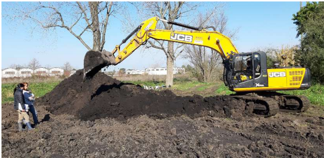
Tareas de excavación en la Brigada de Comunicaciones No. 1.
