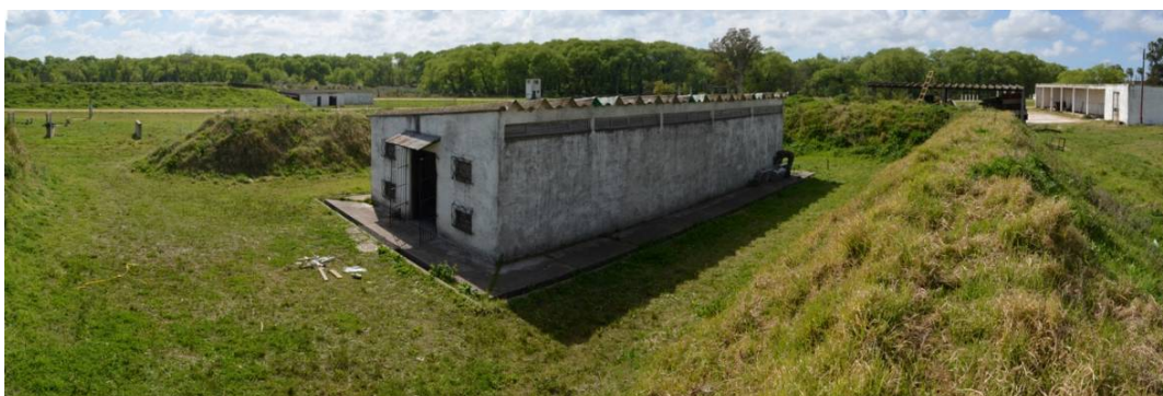
Figura 3. Zona Polvorín con vista panorámica de estructura edilicia o casilla y terraplén de contención.
