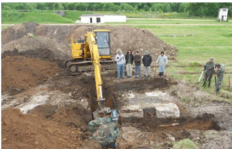
Figura 8. Cuatro estructuras de cemento subsuperficiales, frente al espaldón entre las esquinas 2 y 3.
