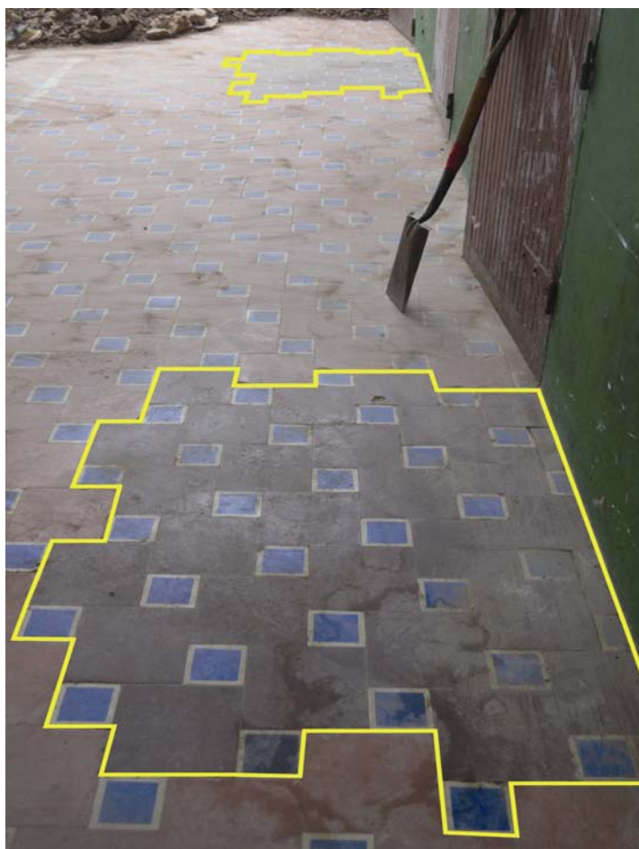
Figura 6. Detalle de sectores señalados por testigo, desde el Sur.
