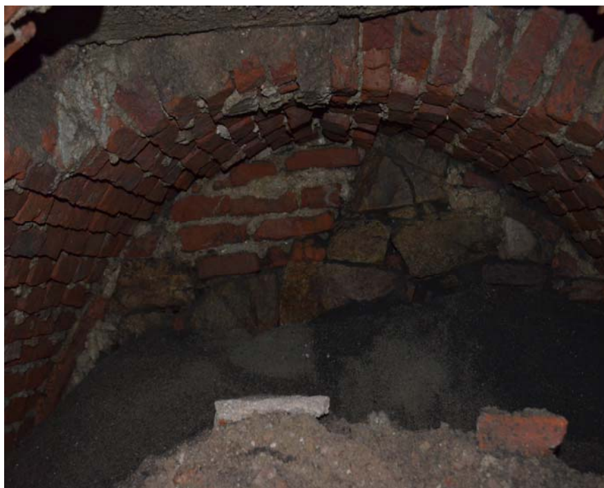
Figura 34. Vista desde el Este de estructura subterránea. Nótese el depósito de relleno (UE03) y la pared W de ladrillo y bloques de roca.
