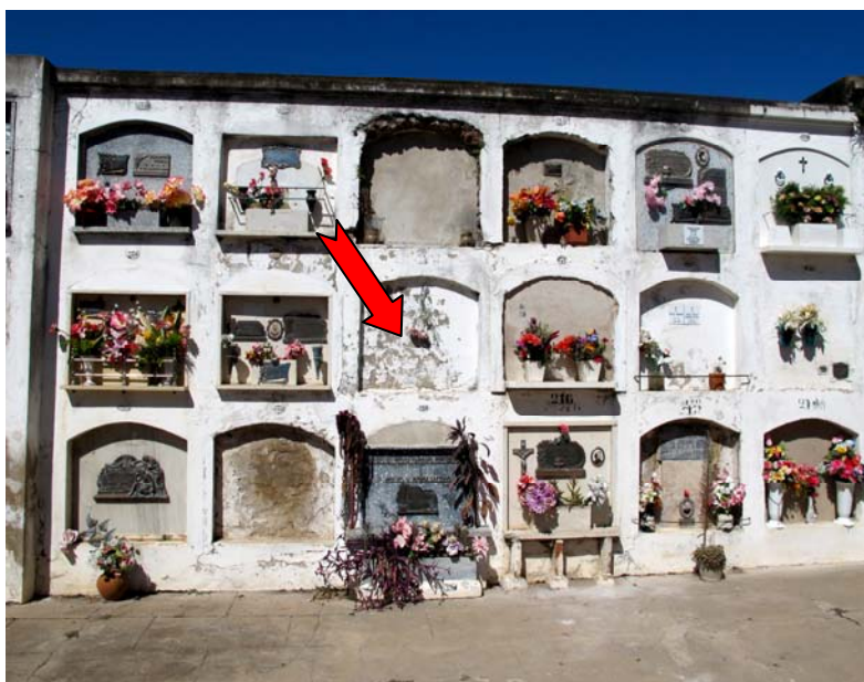
Figura 1. Cementerio de Nueva Palmira. El nicho N° 218 está señalado con una flecha roja.
