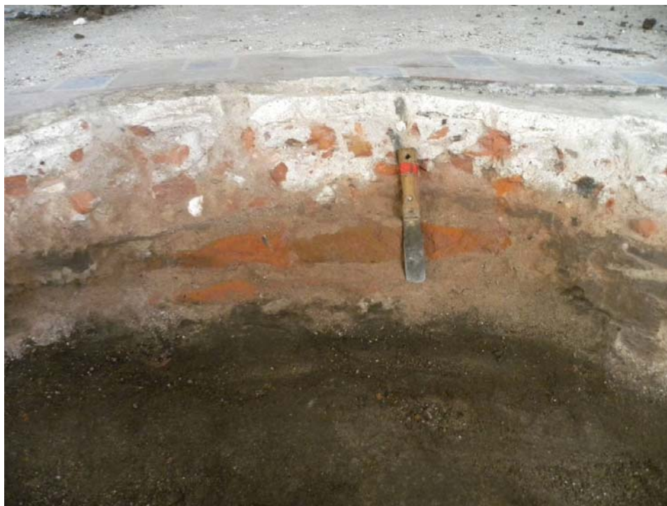
Figura 19. Detalle de la estructura de ladrillos con argamasa de arena y cal.
