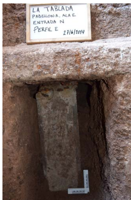
Figura 26. Superior: Vista de zapata corrida en Entrada Norte; Inferior: Detalle de columna de hormigón armado por debajo de la zapata.
