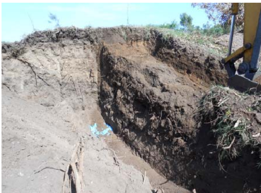
Figura 12. Trincheras Zona V.
