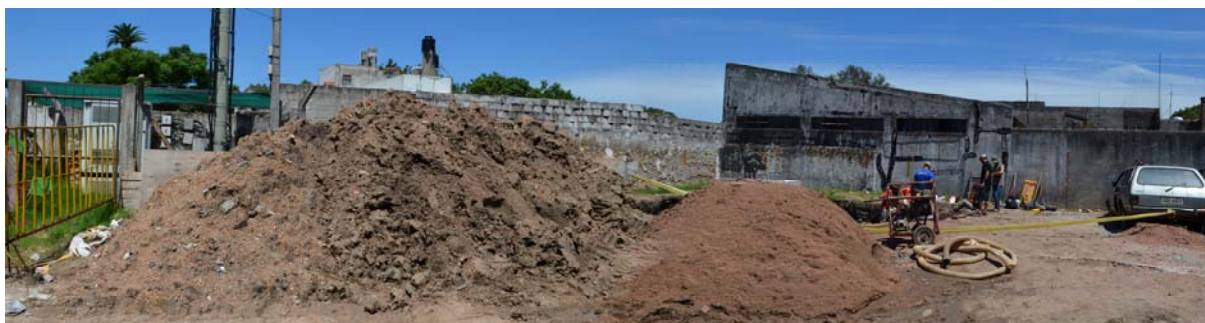
Figura 3. Panorámica donde se aprecia en primer plano la escombrera del pozo de obra.
