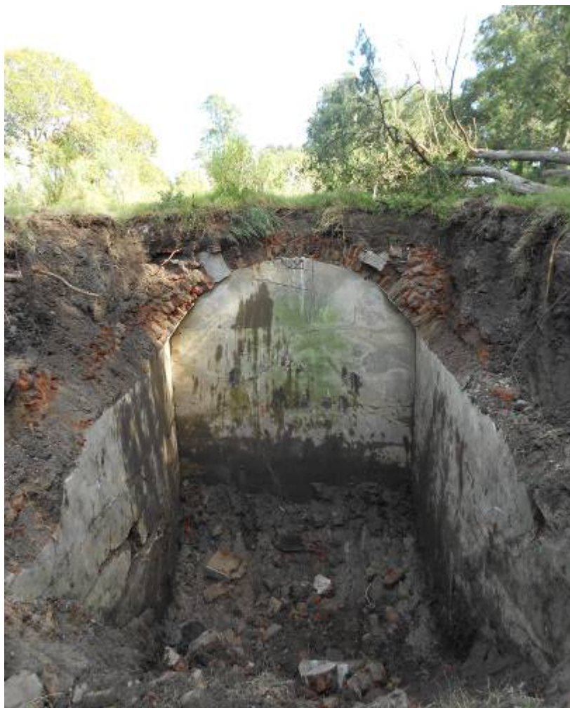
Figura 25. Detalle de proceso de excavación estructura Zona IX
