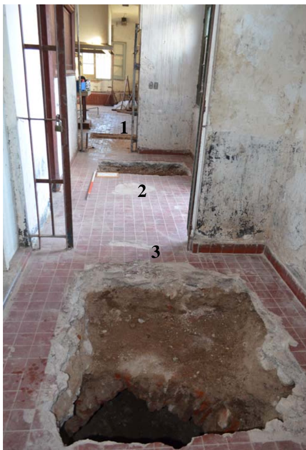
Figura 31. Vista de los sondeos excavados. Sector Cocina: 1. Sondeo 1; Sector Pasillo: 2. Sondeo 2; 3. Sondeo 3.
