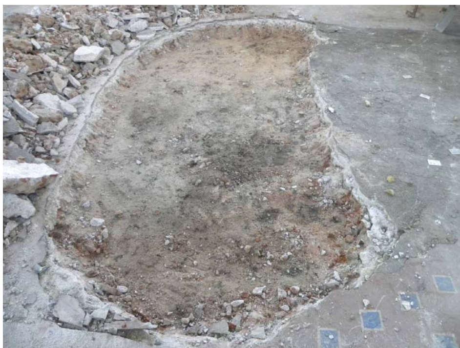
Figura 18. Planta de excavación luego de destapar el relleno de hormigón y la capa de ladrillo con argamasa de arena y portland.
