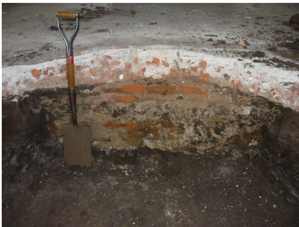
Figura 20. Detalle de muro de ladrillo y depósito arcillo limoso.
