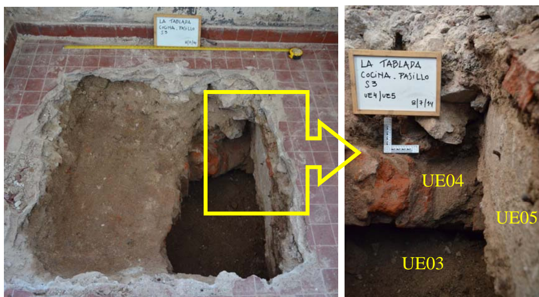
Figura 35. Sondeo 3. Izquierda: vista general de techo de estructura subterránea (UE04). Derecha: detalle del techo de la estructura cortado por una viga de hormigón posterior (UE05).
