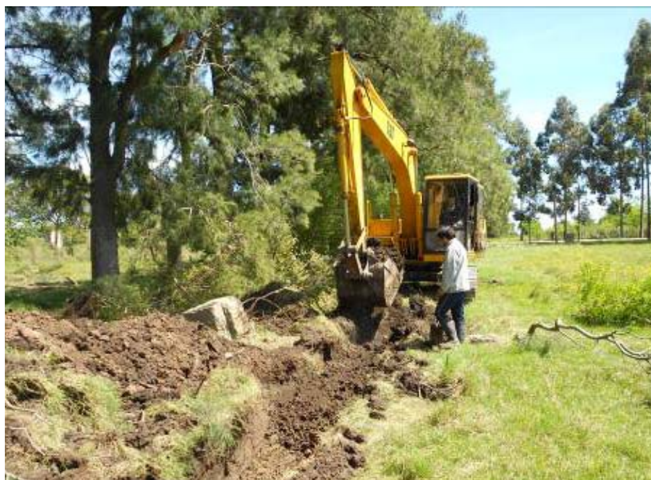
Figura 26. Detalle trinchera en Zona IX
