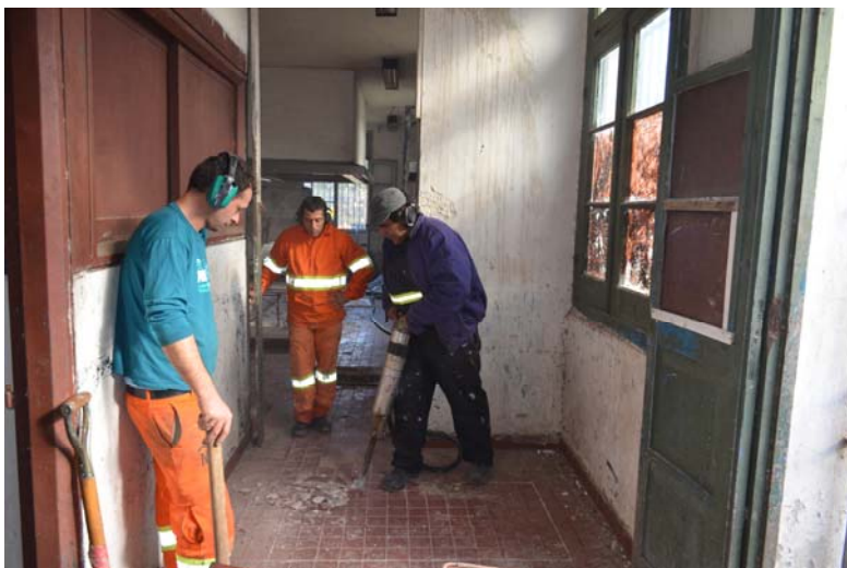
Figura 30. Excavación mediante martillo neumático en Sondeo 2.
