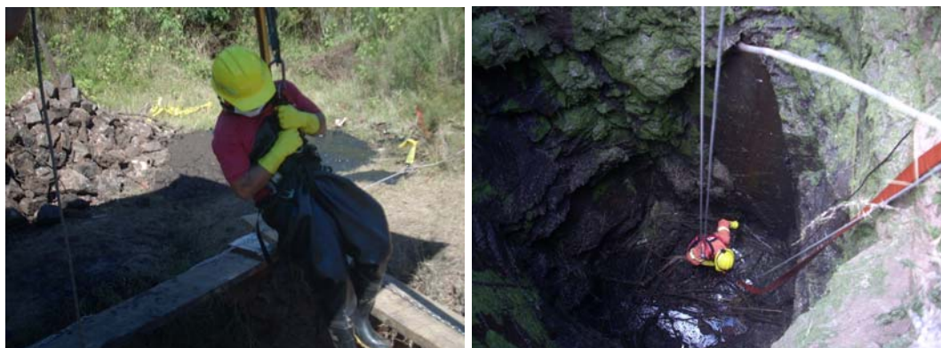
Figura 10. Descenso y ascenso del personal
