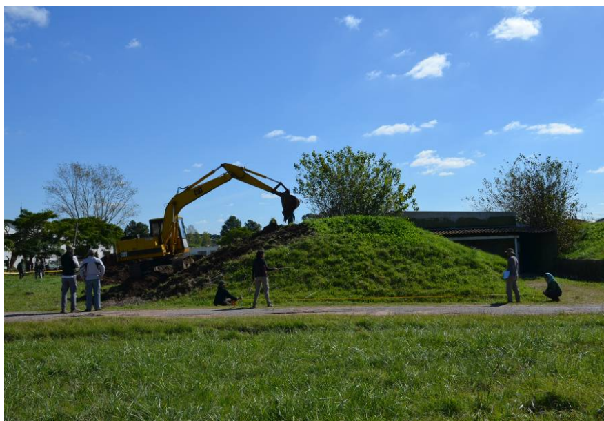
Figura 14. Arriba: Vista panorámica de ZPV1 al inicio de los trabajos con pala retroexcavadora.
