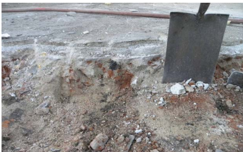
Figura 17. Detalle de la potencia total de la capa de hormigón de 5 cm aproximadamente.
