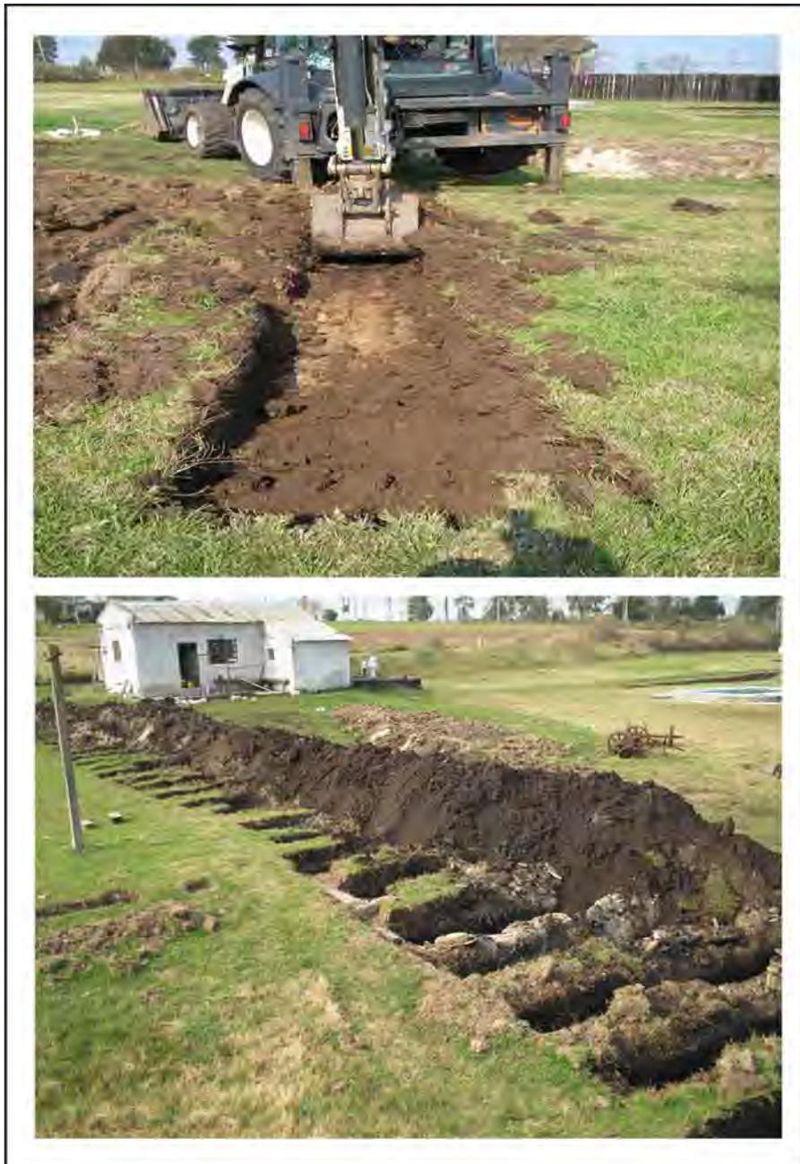
Figura 20-. Excavaciones con maquina retroexcavadora
