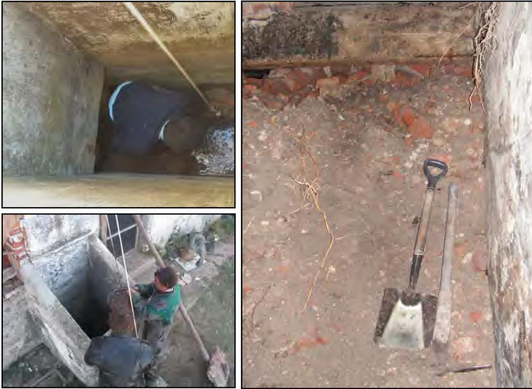
Figura 12. Vista interior de la habitación, donde se observa el material de relleno (derecha) y el trabajo de vaciado correspondiente (izquierda).
