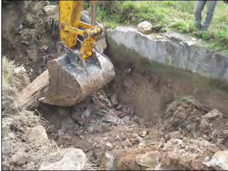
Figura 26. Vaciado del relleno.
